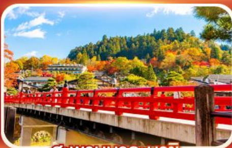
สะพานนากะบาชิ
