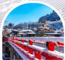
สะพานนากะบาชิ
