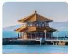
สะพานเจียงเฉียว
